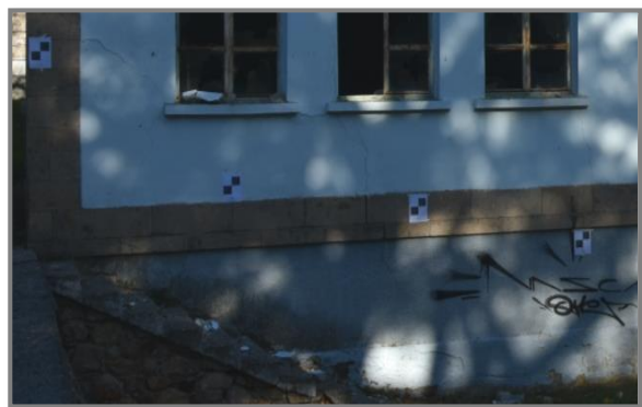
Εικόνα 1: Τοποθετημένοι στόχοι στην πρόσοψη του κτηρίου
