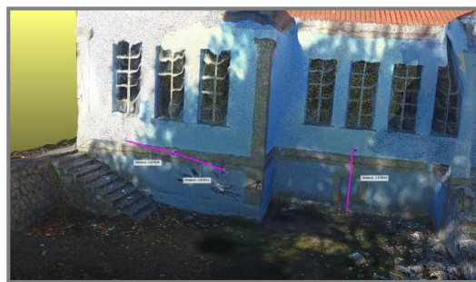
Εικόνα 4: Μετρήσεις ευκλείδειων αποστάσεων στο 3D νέφος σημείων, Top-Down
